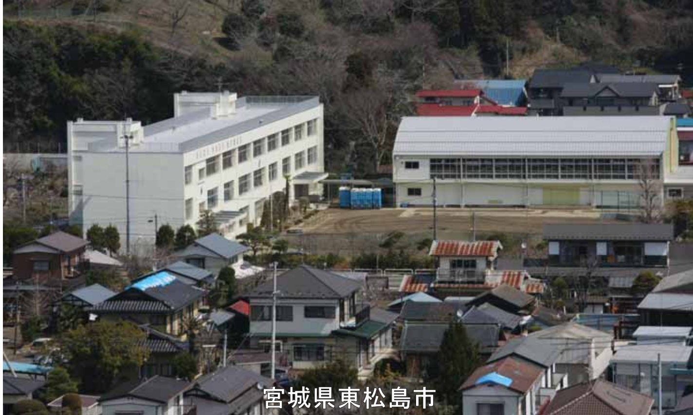
2302_2_018_014942_東松島市(広報)_2011.4.10_災害状況空撮_鷹来の森～宮戸・野蒜 _小野小学校周辺
