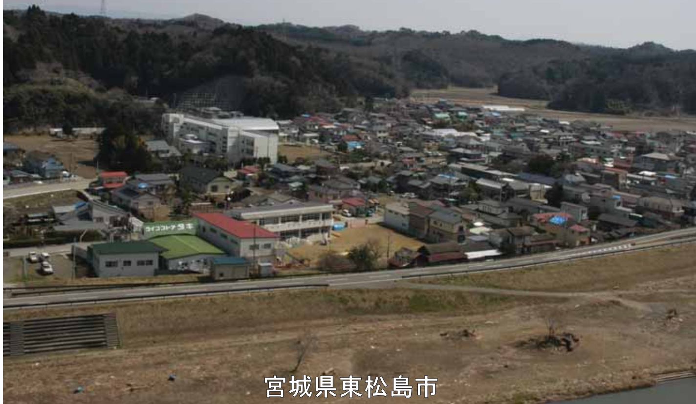
2302_2_018_014920_東松島市(広報)_2011.4.10_災害状況空撮_鷹来の森～宮戸・野蒜 _小野小学校周辺
